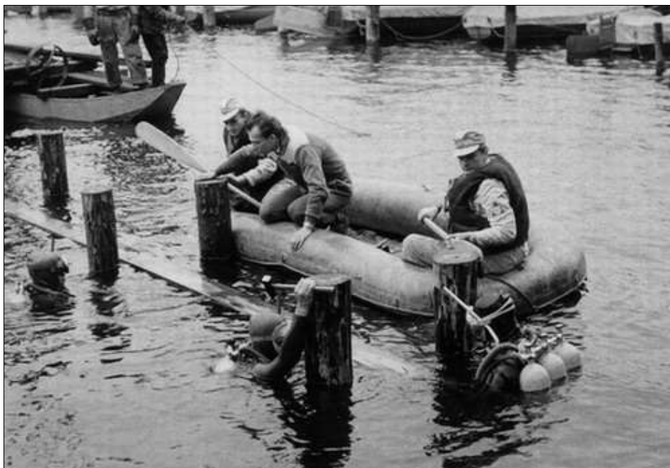
Im Oktober 1960 - Hilfsarbeiten beim Bau eines Bootssteges auf Valentinswerder /Tegeler See
